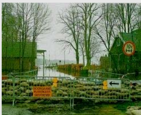
Рис. 17: Мешки с песком для защиты от паводка \ паводок на Рейне
