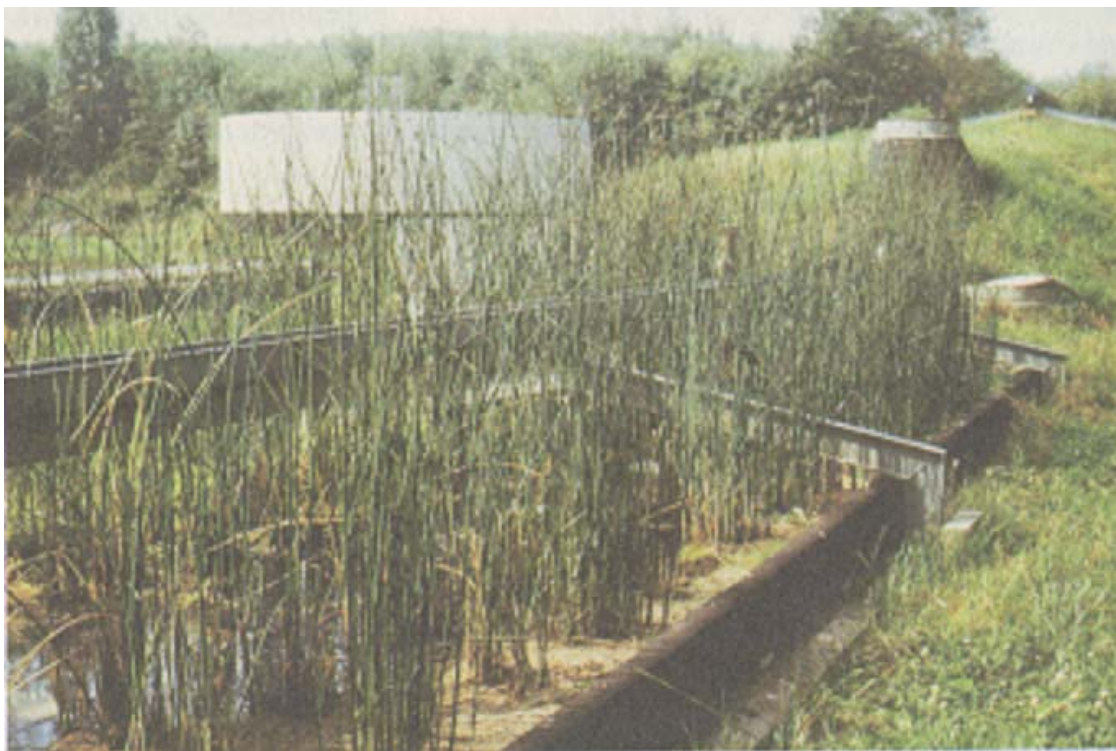
Рис. 23: Растительная очистная установка [22]
