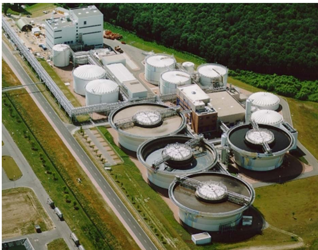
Рис.14: Совместная очистная станция Биттерфельд [биол. реакторы – 453 000 ЕW] (Пилотный проект Федерального Министерства охраны окружающей среды совместной обработки бытовых стоков и сточных вод химических предприятий) [5]
