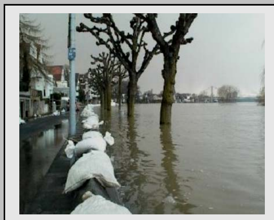
Рис. 17: Мешки с песком для защиты от паводка \ паводок на Рейне
