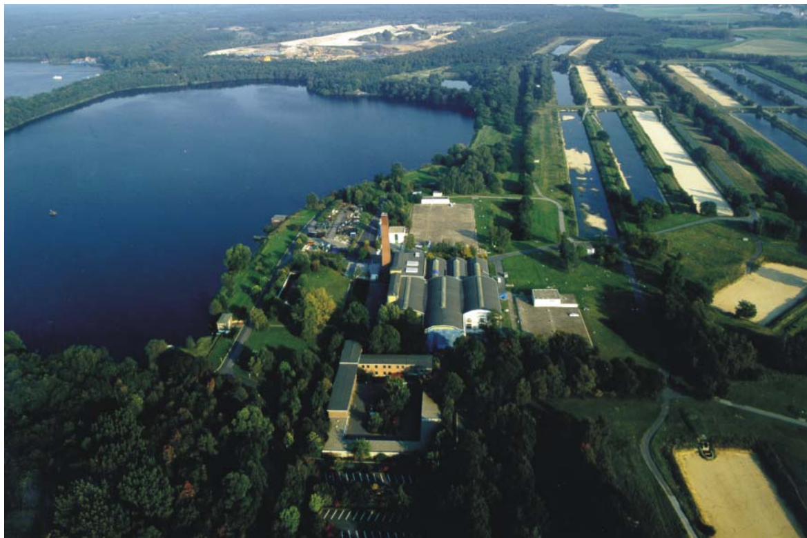
Рис. 24: Станция водоподготовки Халтерн
