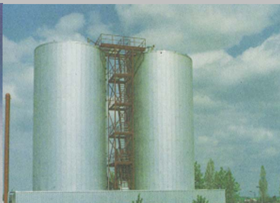
Рис.34: Биореактор для сбраживания загрязненных органикой сточных вод [15]
